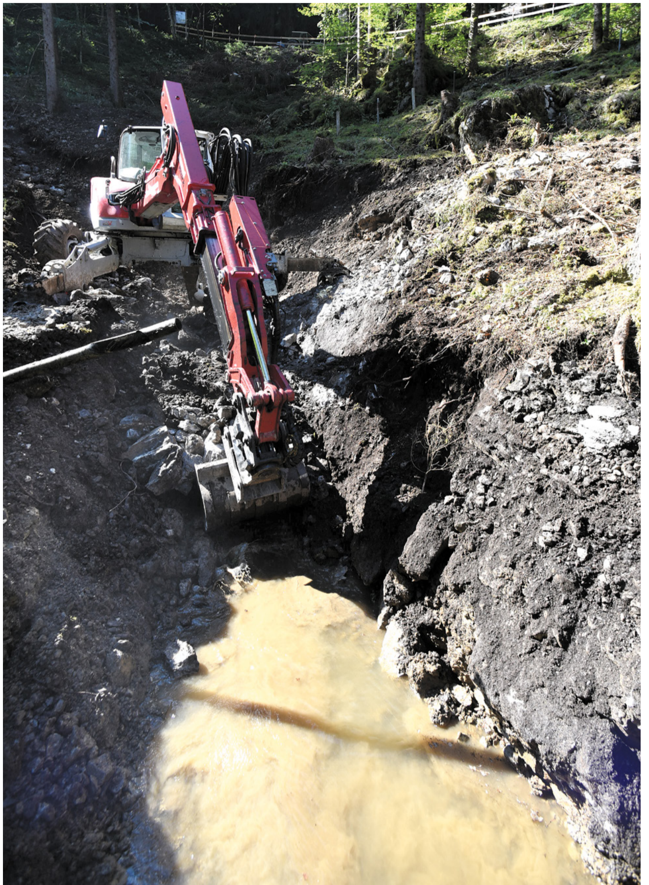
Nachdem die hinteren Quellen im Gebiet Gätterli seit Dienstag neu gefasst und mit einem mehrschichtigen Aufbau geschützt sind, geschah Gleiches am Mittwoch bei den vorderen, die sich unterhalb der Seealpstrasse am Hangfuss befinden. Die Aufnahme zeigt, wie Quellwasser das durch die Entfernung von Erd- und Gesteinsmaterial aufgewirbelte Wasser verdrängt. Im Schreitbagger sitzt Maschinist Josef Gmünder von der «Zimmermann AG».
