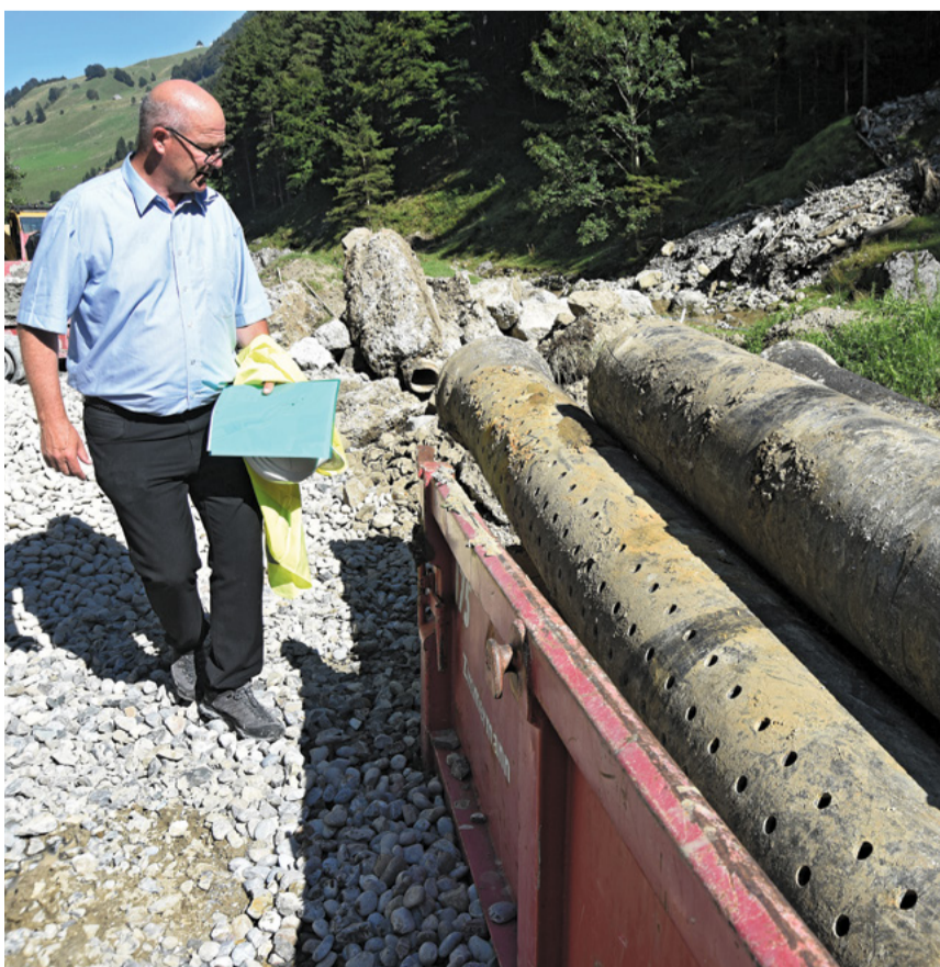
Hanspeter Koller, Betriebsleiter der Feuerschaugemeinde Appenzell, begutachtet die ausgebauten – fast 100 Jahre alten – Gussrohre der bisherigen Quellfassungen. (Bilder: H9)
